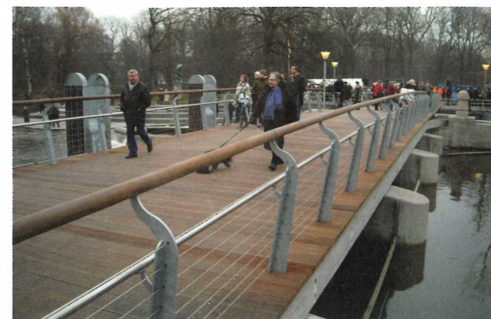
Bro over Odense kommunes fiskepassageprojekt omkring Odense Å ved Munke Mose.
